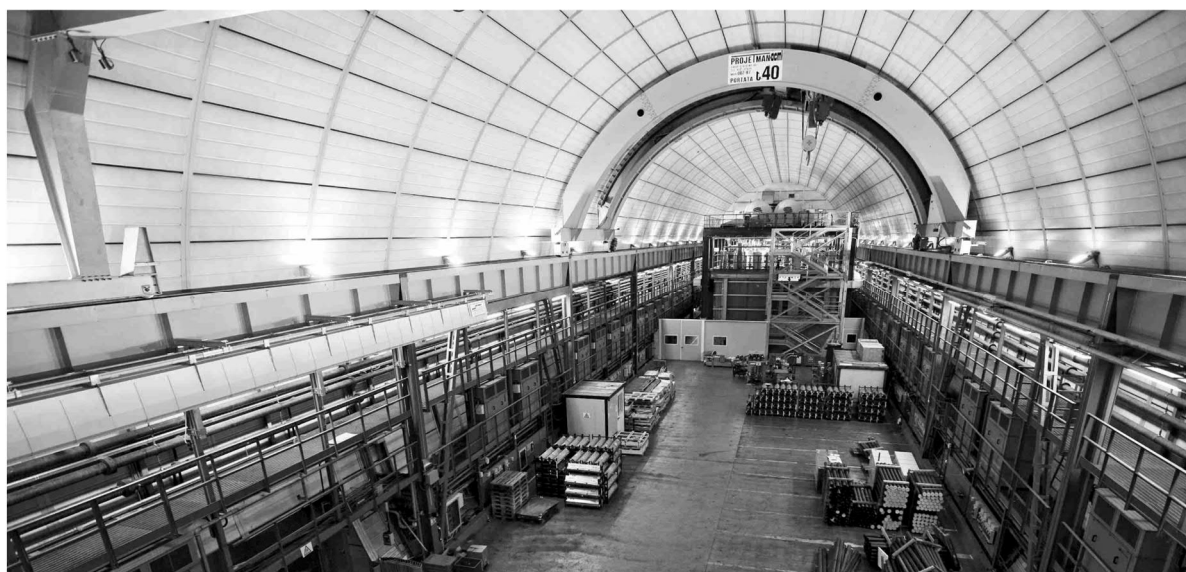
Ilustración 8: Ejemplo de puente grúa con viga principal curva (fuente: LNGS, Assergi, Italia)
